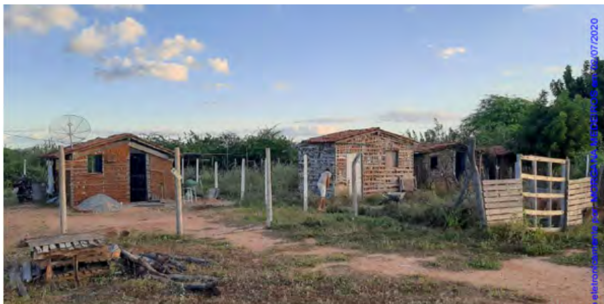
Habitações Precárias Construídas no Assentamento Serrote Liso
